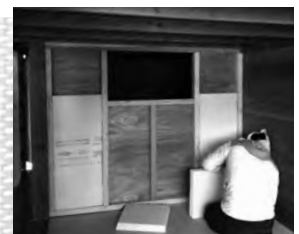
蝶ヶ岳ヒュッテでは、相部屋に仕切りを取り付ける工事を進めている
